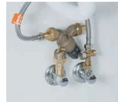
Plaats het mengventiel op een van de hoekstopkranen.
