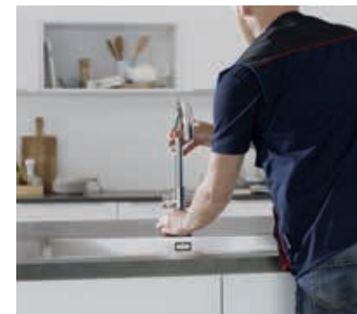
Plaats de kraan en monteer deze met de fixatie-set op het keukenblad.
